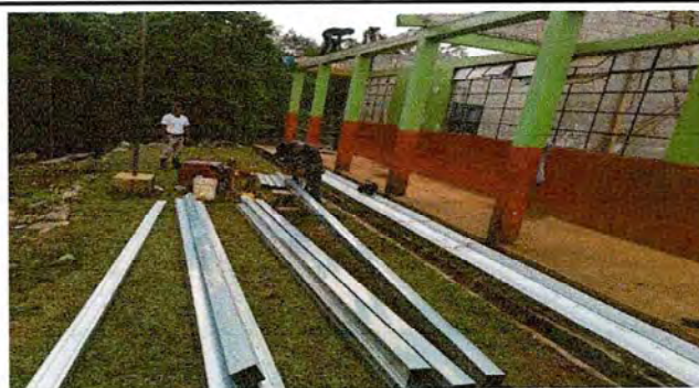
Foto 4: Preparando las costaneras para sustituir anterior estructura.
