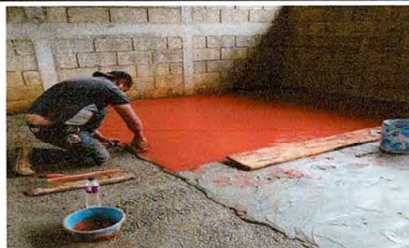
Foto 2: Aplicación de pintura a piso de concreto sustituido.
