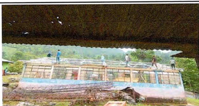
Foto 5: Instalando las costaneras nuevas
