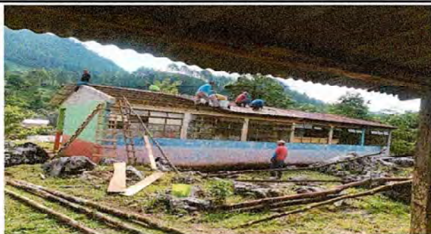
Foto1: Destechado de las dos aulas
