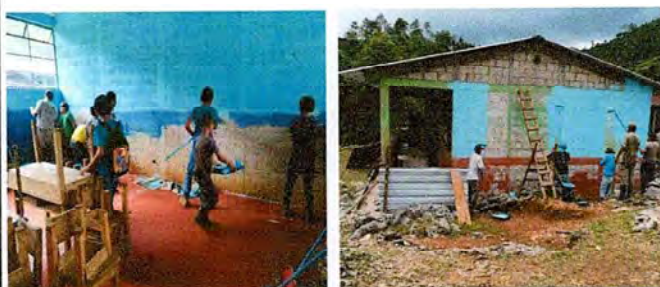
Foto 3: Aplicación de pintura en pared interior y exterior.
