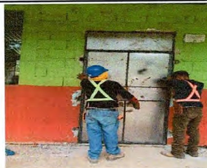
Foto 6: Instalando de puertas de las aulas remozadas
