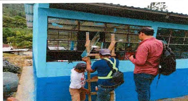
Foto 4: Sustitucion de Vidrios en ventanas de aula.
