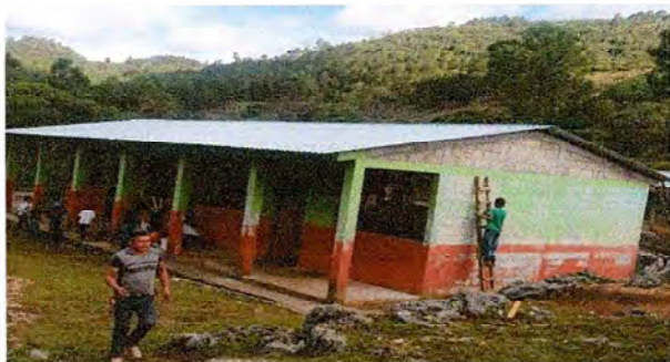
Foto1: Limpieza de paredes exteriores de aulas.
